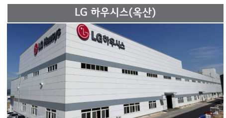
PCS : 500kW / 배터리 : 1.5MWh 부하 이동용
