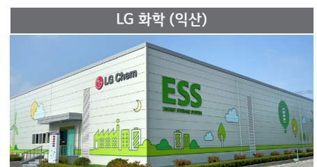
PCS : 3MW / 배터리 : 23MWh 부하 이동용
